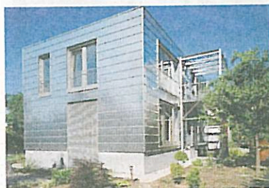
Objekt: Atelier-Wohnhaus, Dornbirn Bauherr: U. Belina-Waeger Architektur: Heinz Waeger
