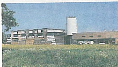
Objekt: Zimmerei Berchtold HZB, Wolfurt Bauherr: Julius Berchtold Architektur: Gerold Leuprecht GmbH
