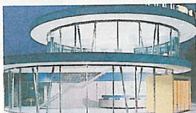
Objekt: Firma Sonnroll, Höchst Bauherr: Sonnroll Architektur: Bernhard Bügelmayer
