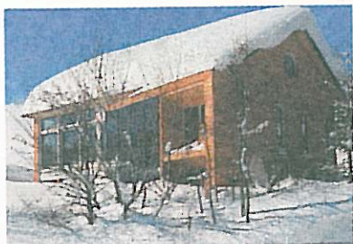
Objekt: 3-Liter-Biohaus, Riezern Bauherr: Walter Grabherr Architektur: Manfred Stadelmann
