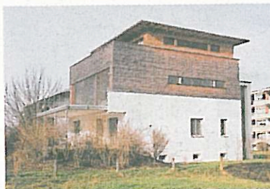
Objekt: Zu- und Umbau, Dornbirn Bauherr: Günter Rümmele Architektur: Simma-Strasser & MM3
