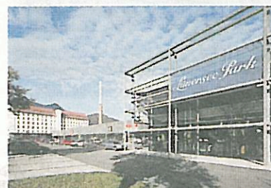
Objekt: Lünserseepark & -fabrik, Bürs Bauherr: Innova Projektentw. GmbH Architektur: Innova & Nikolussi
