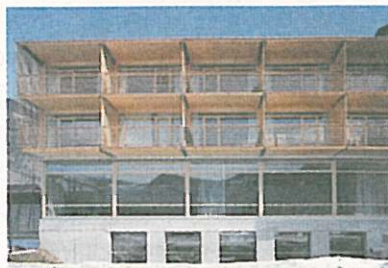
Objekt: Hotel Post, Bezau Bauherr: Hotel Post Kaufmann GmbH & Co Architektur: Kaufmann & Kaufmann
