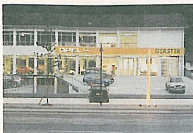
Objekt: Umbau Opel Gerster, Feldkirch Bauherr: Auto Gerster GmbH Architektur: Wimmer & Armellini
