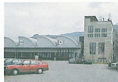
Objekt: Wasserturm, Dornbirn Bauherr: Ronald Schwarz Architektur: Andreas Weratschnig
