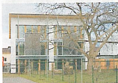
Objekt: 4 Doppelhäuser, Feldkirch Bauherr: Konzelt, Bau-Tech GmbH Architektur: Richard Caldonazzi
