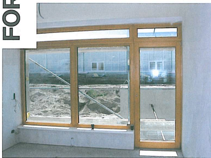
Abb. 4: solarCity Linz: Verglasung mit TWD Element
