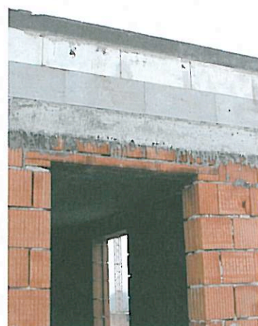
Abb. 7: Attikaausführung mit Gasbetonsteinen. Fotos Wilhelm Hofbauer (7)
