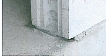
Abb. 11: Gasbetonsockel beim Ziegelmauerwerk
