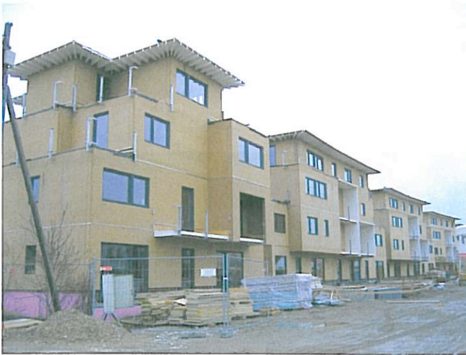
Abb. 12: Klima.Komfort.Haus: Rohbauten. Foto: Haselsteiner
