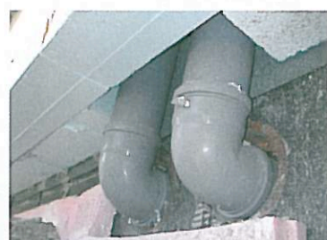
Abb. 9: Führung der Solarleitungen in der Außenwand
