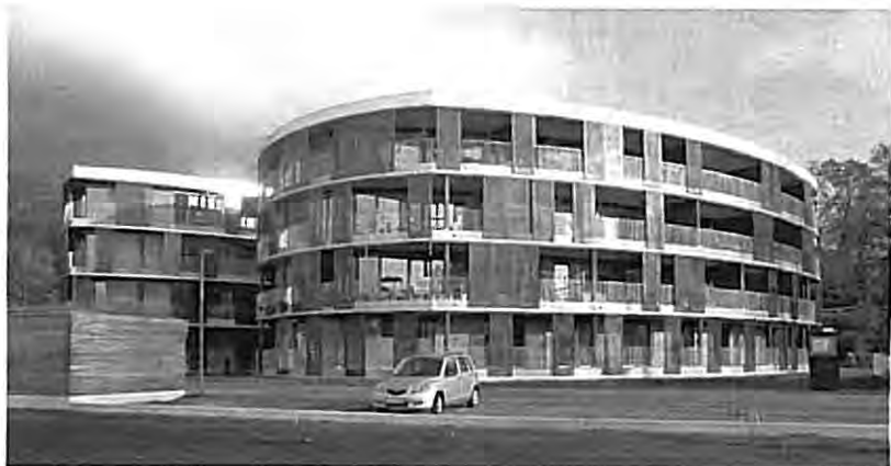
Abb. 3 – Die Wohnanlage Sandgrubenweg des Architekten Wolfgang Ritsch mit Hörburger, Kuess und Schweizer wurde von 2006 bis 2010 in Bregenz (Vorarlberg) gebaut und gehört zum Forschungsprogramm „Haus der Zukunft“.
