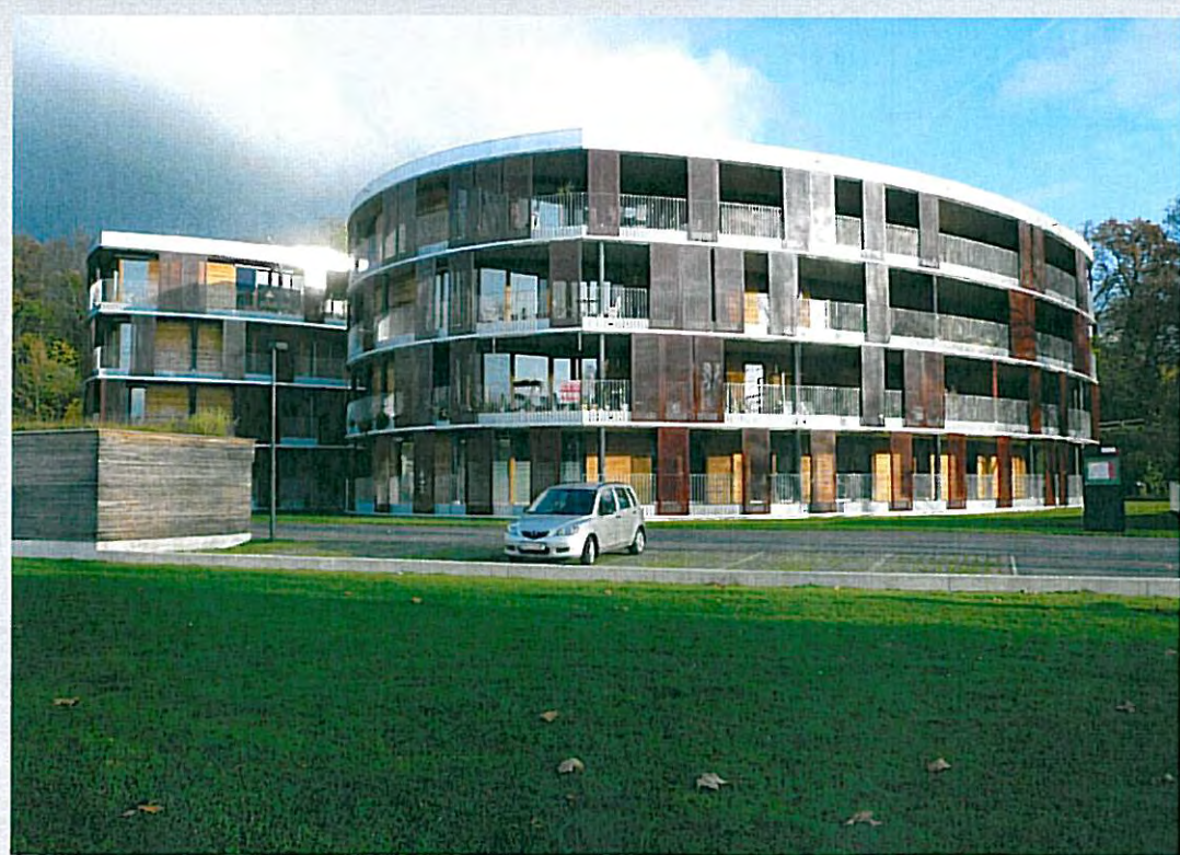
Wohnanlage Sandgrubenweg von Wolfgang Ritsch mit Hörburger, Kuess und Schweizer in Bregenz (Vorarlberg) – Foto: Dominique Gauzin-Müller
